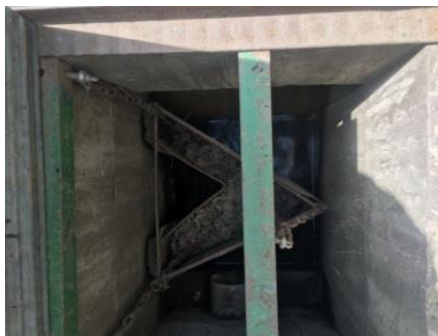
油水分離槽内
